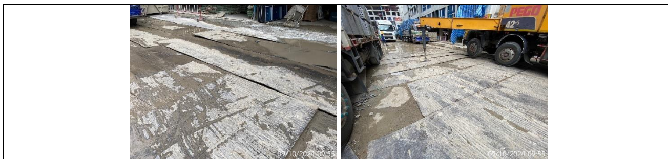
รูปที่ ผ7.24 แผ่นเหล็กอย่างหนาปูให้ทั่วบริเวณภายในพื้นที่โครงการ ในช่วงก่อสร้าง
