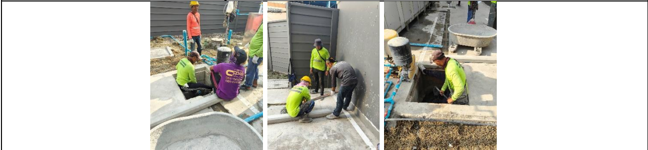
รูปที่ ผ7.58 ขุดลอกตะกอนท่อระบายน้ำชั่วคราว และบ่อดักขยะ/ตะกอนดินภายในโครงการ
