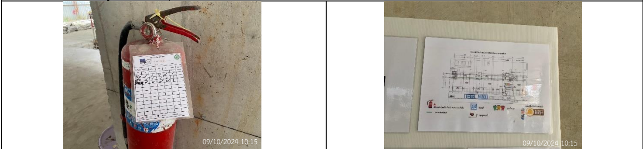
รูปที่ ผ7.59 การตรวจสอบถังดับเพลิงให้อยู่ในสภาพใช้งาน ในช่วงก่อสร้าง
