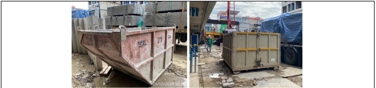
รูปที่ ผ7.49 กระบะเหล็กสำหรับใส่เศษวัสดุก่อสร้างต่าง ๆ เพื่อนำไปใช้ประโยชน์ หรือกำจัดต่อไป ในช่วงก่อสร้าง
