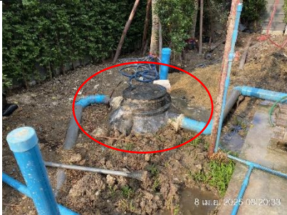
รูปที่ ผ7.31 ถังบำบัดน้ำเสียสำเร็จรูป ในช่วงก่อสร้าง
